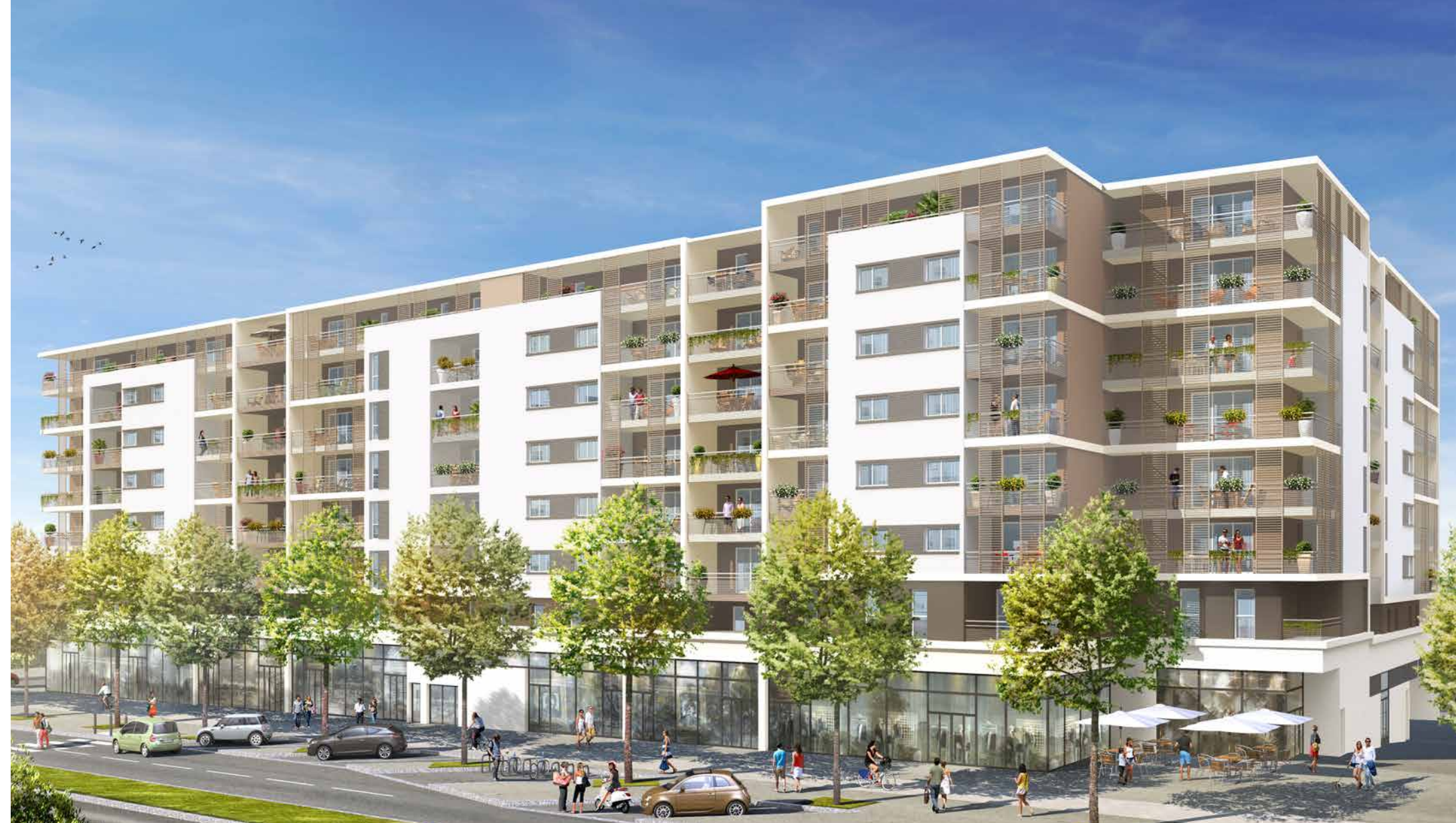
Vue de la Résidence et de ses commerces sur le Boulevard de Pont de Vivaux
